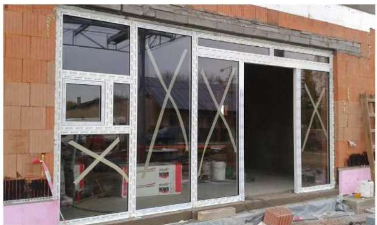
Prosklená AL vstupní stěna ČSPH Rožďalovice
