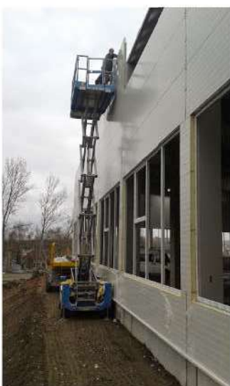
Opláštění haly - Car Wash Pízeň
