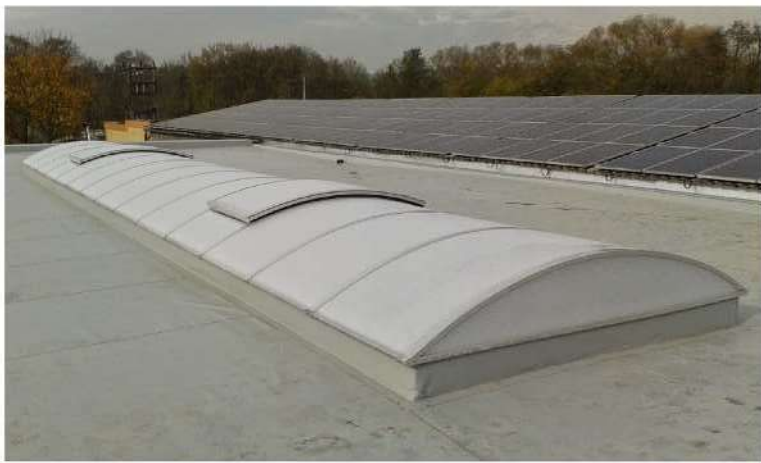
Nosné trapézové plechy a hliníkový obloukový světlík zasklený polykarbonátem - Kovovýroba Staňkov
