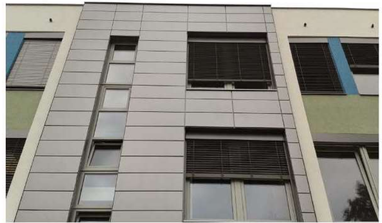
envi-pur Soběslav - Provětrávaná fasáda Dekmetal
