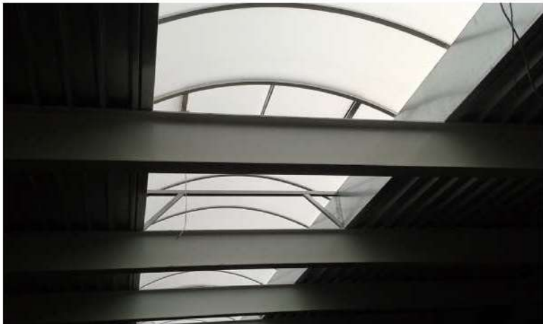
Nosné trapézové plechy a hliníkový obloukový světlík zasklený polykarbonátem - Kovovýroba Staňkov
