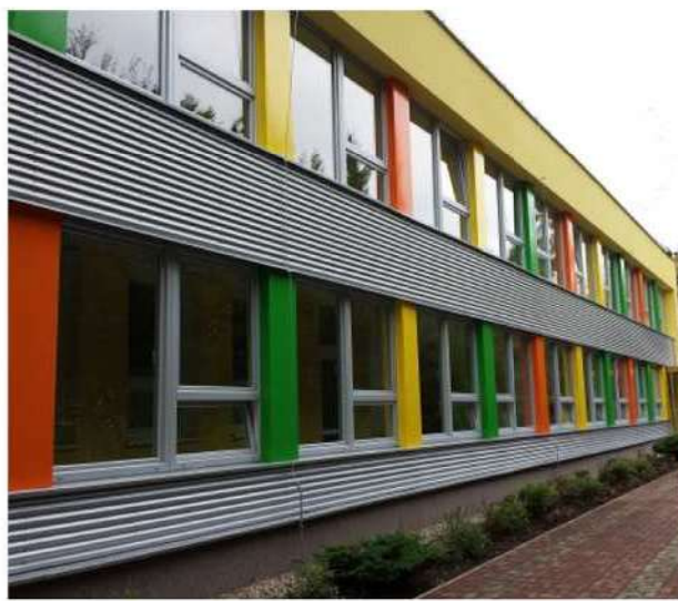
MŠ Přetlucká - barevná ocel. fasáda a nosná podkonstrukce
